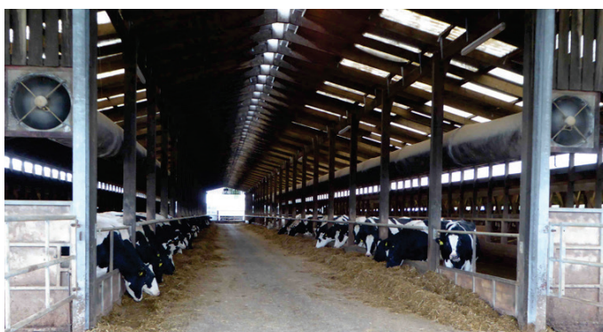
Schlauchlüftung über dem Futtertisch-Ansaugen frischer Luft von außen
