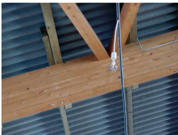
Beregnungsanlage für Milchkühe
