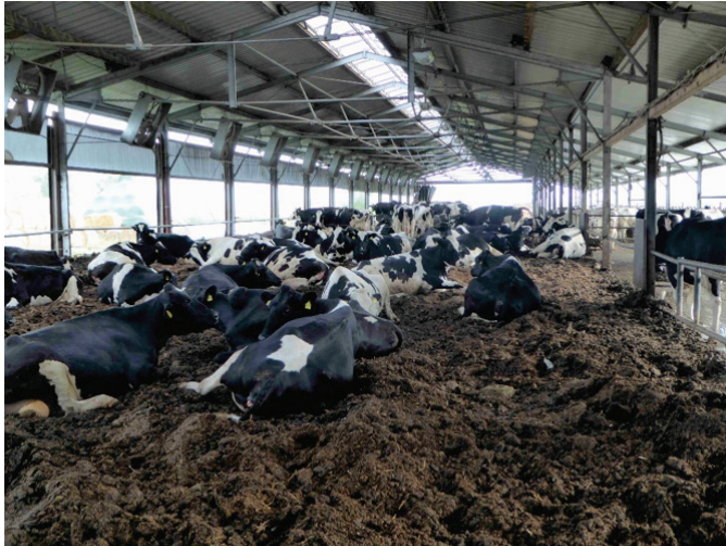
Axial-Ventilatoren über einem Kompostierungsstall in Querlüftung/-richtung
