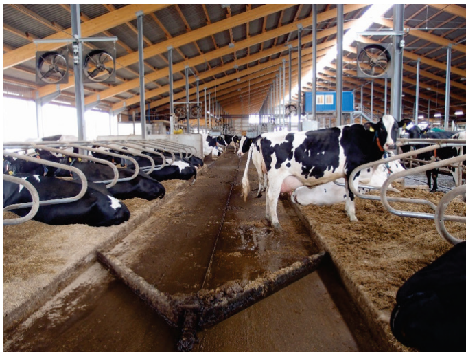
Axial-Ventilatoren über den Liegeflächen in Längsrichtung
